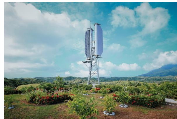
垂直軸型マグナス式風力発電機 (マグナス風車)
