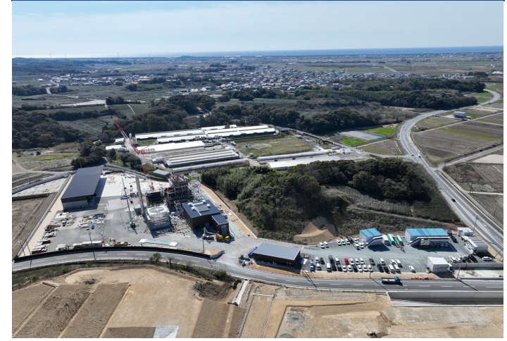
Enshu Forest Energy BTG 7.1MW、建設中
